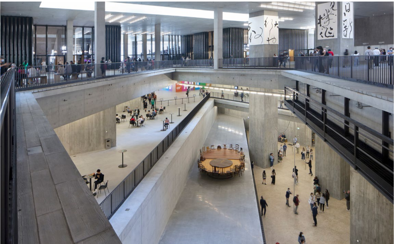
每层巨大的开口可加速烟雾扩散, 增加火灾事故所引发的风险。
