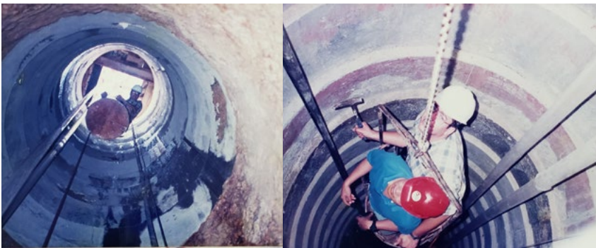
1995年, 麦华利斯检查屯门公路扩建加宽工程的人工挖孔桩护壁。
